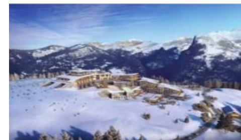
Club Med Samoëns – 420 chambres
